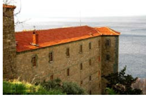
الواجهة الشمالية للدير
